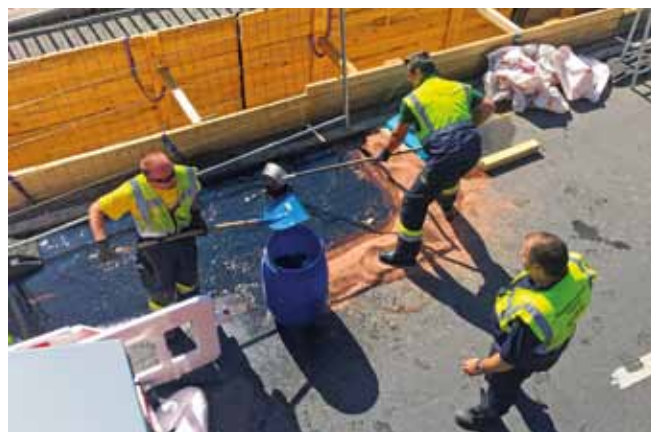
Eher ungewöhnlich: Mit Schaufeln und Schöpfern wurde der Diesel aufgenommen.
