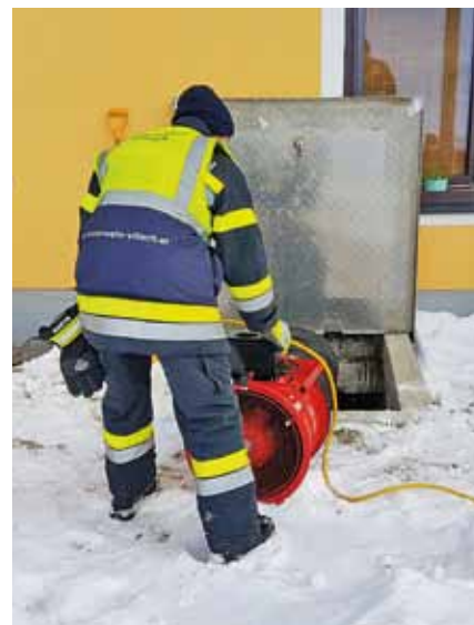
Die Kellerräume wurden über eine Schachtoffnung belüftet.
