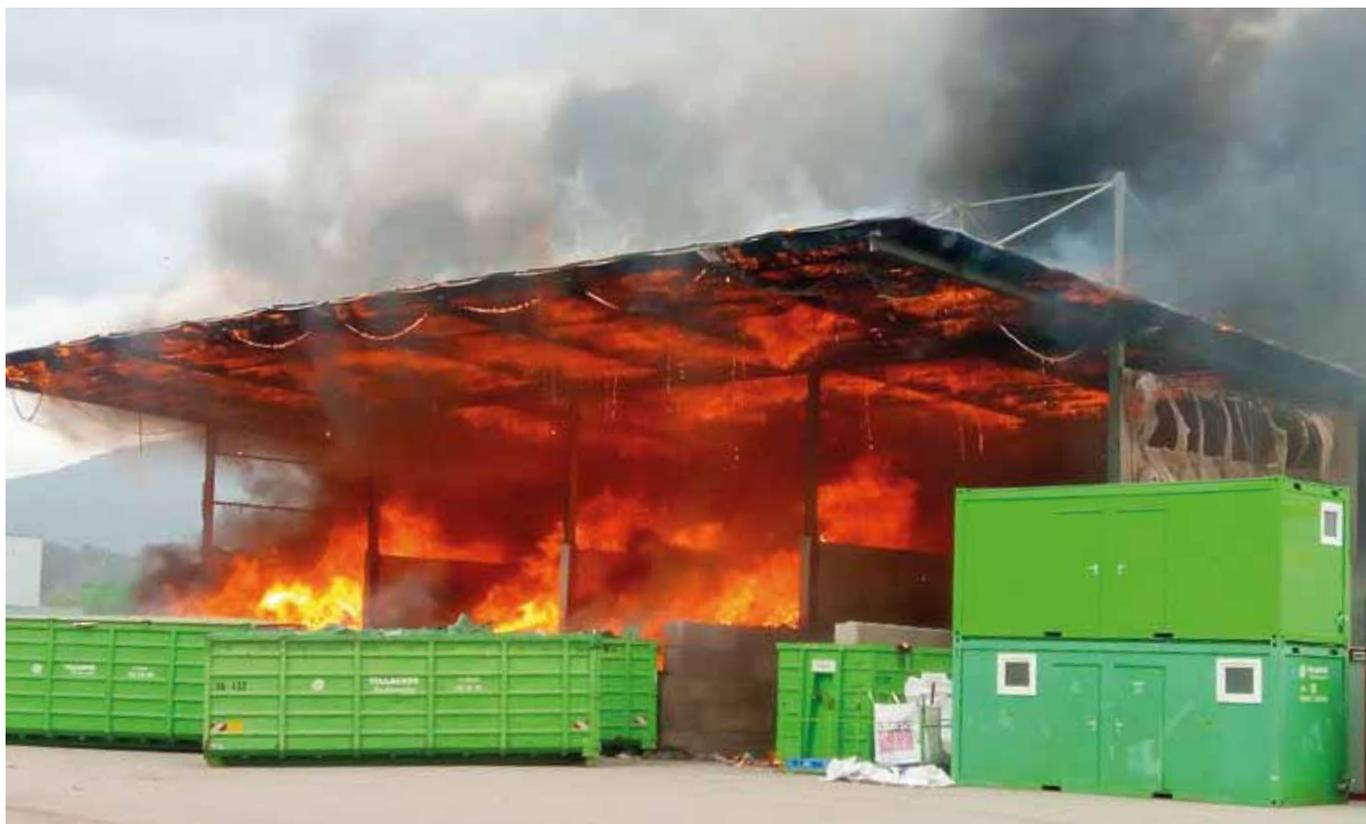
Durch die Dachkonstruktion wurde die Wärmestrahlung nach vorne sehr verstärkt. Einige Container konnten mit dem Radlader der Firma Saubermacher aus dem Gefahrenbereich gezogen und gesichert abgestellt werden.
