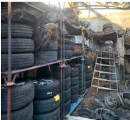
Einige hundert Reifen verbrannten in diesem Lagerbereich. Auch die Deckenkonstruktion stürzte ein.
