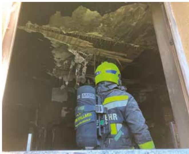
Die Küche brannte zur Gänze aus. Das Feuer beschädigte auch Teile der Deckenkonstruktion, welche in weiterer Folge mit Baustehern unterstellt und gesichert werden musste. Eine Ersatzwohnung wurde seitens der Stadt Villach bereitgestellt.
