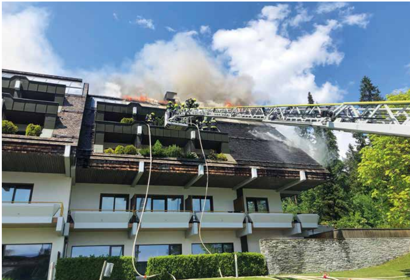
Durch einen kombinierten Innen- und Außenangriff konnte der Brand glücklicherweise im betroffenen Gebäudeteil gehalten werden.
