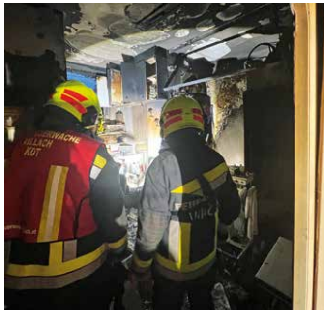
Ein Blick in den völlig ausgebrannten Bereich des Geschäftes.
